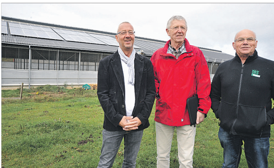
Manfred Stoffels, Hans Niessen und Karl Miessen (von links) vor dem Kuhstall an der Weimser Straße, wo derzeit im Auftrag von Courant d'Air eine 80 Kilowatt starke Fotovoltaikanlage installiert wird. Foto: Helmut Thönnissen
